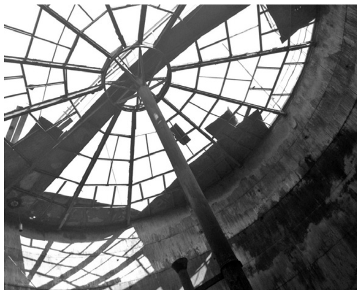
Рисунок 1. Демонтаж производственного оборудования
