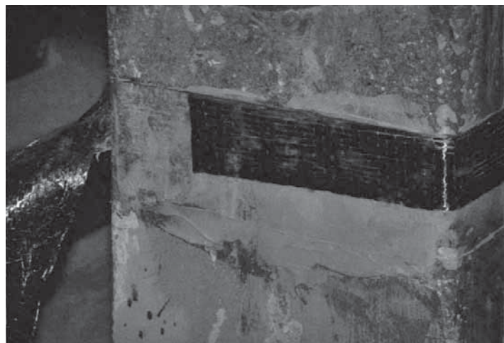
Рисунок 1 Приклеивание композиционного материала на поверхность бетона с помощью клея Sikadur
